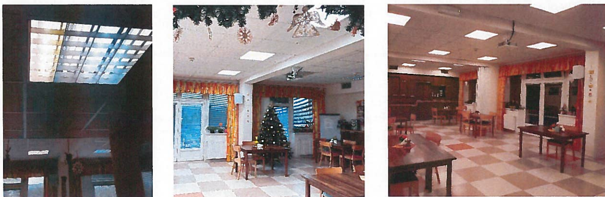
Obrázek 4: Osvětlení jídelny A – detail původního svítidla s odraznými mřížkami; B – srovnání původního osvětlení (v pravé části snímku) s novým osvětlením (vlevo) v denním režimu; C – nové osvětlení ve večerním režimu.
