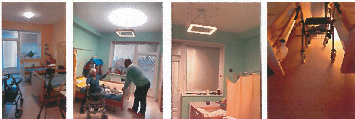
Obrázek 2: Osvětlení pokojů klientů. Původní osvětlení (A) bylo nahrazeno biodynamickým, které upravuje spektrální složení, charakteristiku vyzařování a intenzitu v závislosti na denní/večerní době (B, C). Pro noční pohyb byly pokoje vybaveny nočním orientačním osvětlením (D).
